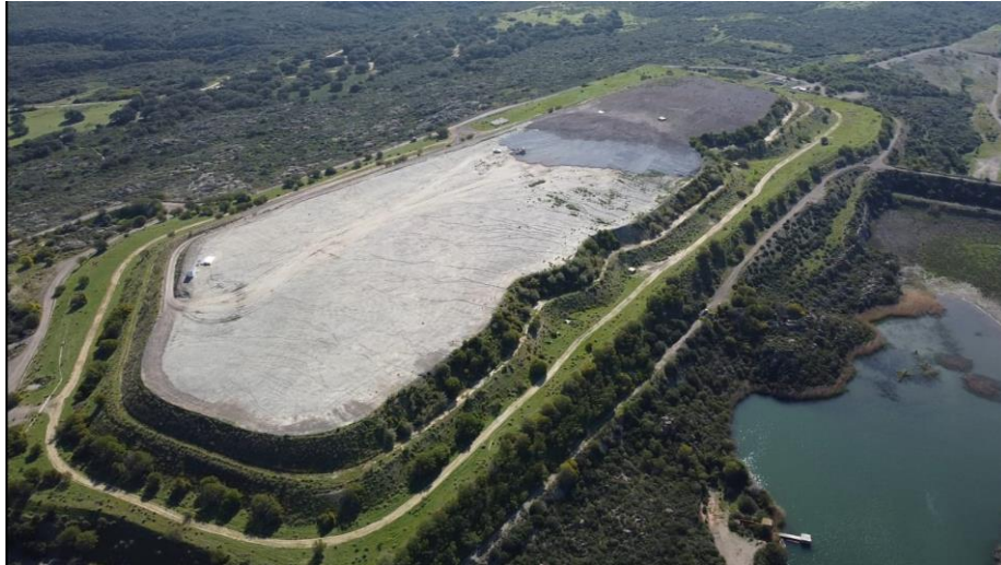
Fig. 2 –Discarica RNP Carbosulcis – Stato dei lavori al 03/04/2024
