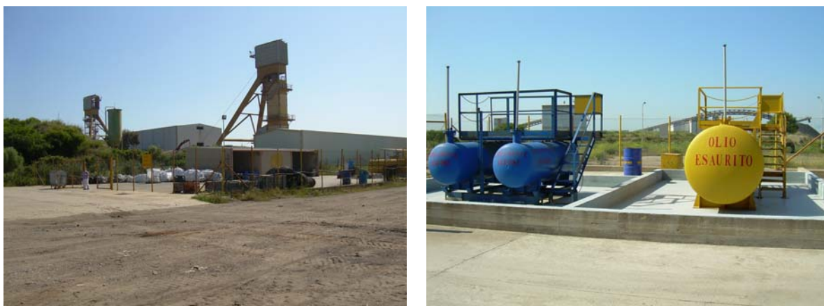
Fotografia 12: Viste del Deposito Temporaneo di Rifiuti Speciali
