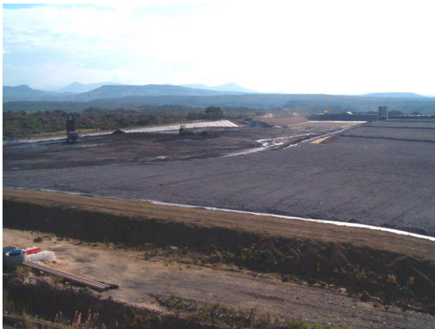
Fotografia 6: Vista Generale della Discarica per Rifiuti Non Pericolosi
