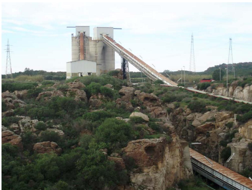
Fotografia 3: Vista da Laveria dei Sili per lo stoccaggio temporaneo di Carbone e Sterili
