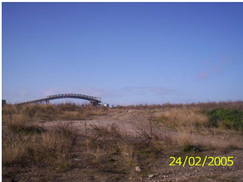
Fotografia 14: Particolare Area Ubicazione Impianto di Pompaggio
