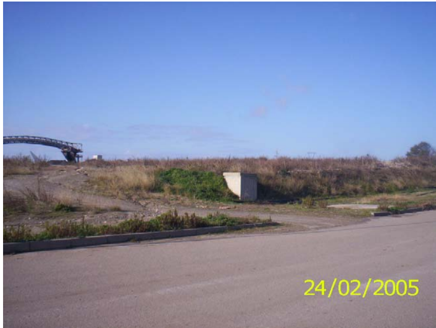
Fotografia 13: Vista generale Area Ubicazione Impianto di Pompaggio
